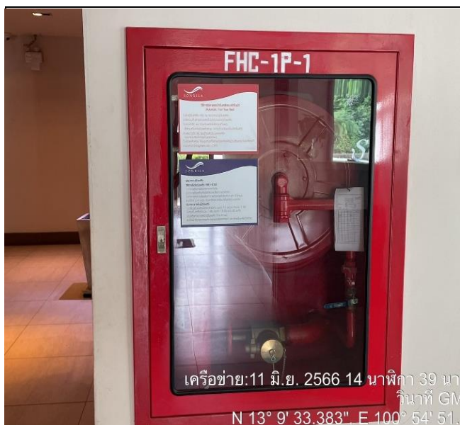
รูปที่ 2.4.7.3-1 ตู้เก็บสายฉีดน้ำดับเพลิงพร้อมอุปกรณ์
